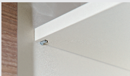
Półki w szafkach wiszących zabezpieczone przed wysunięciem.
