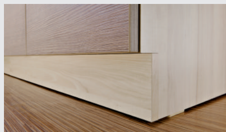
Boki szafek dolnych podcinane w celu zachowania jednej linii cokołu.
